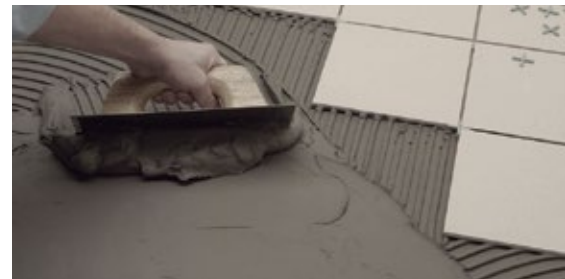
Aplicación del adhesivo. Adhesive material application.
