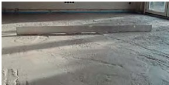
Preparación del soporte. Preparing the support.
